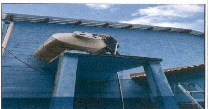
Foto 6: Sustitución de deposito de agua 1100 lt
