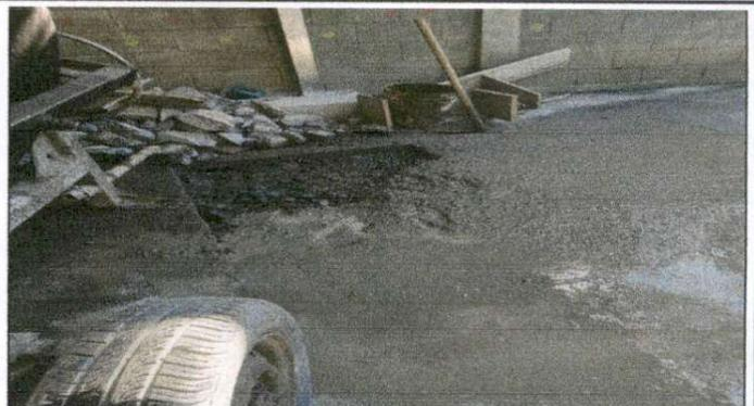
Foto 2: Reparación de piso de torta de concreto
